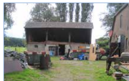
Het erf met het achterhuis van de boerderij en karakteristieke kapschuur. De kapschuur is op de begaande grond gesloten. Het erf is onverhard, met deels halfverharding van puin.
