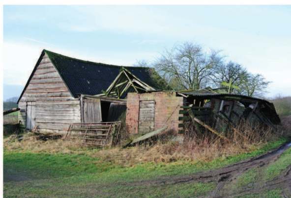
bestaande voor- en rechter gevel (zuid)
