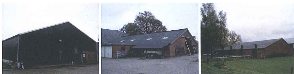
Foto's: De te slopen opstallen: de kapschuur, koeienstal en de varkensstal.
