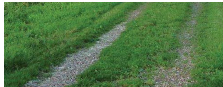
A Boerengrind (bestaand) op het pad
