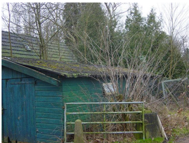
Foto 6, de achterzijde van het bakhuis (3) met de houten garage, kippenschuur.
