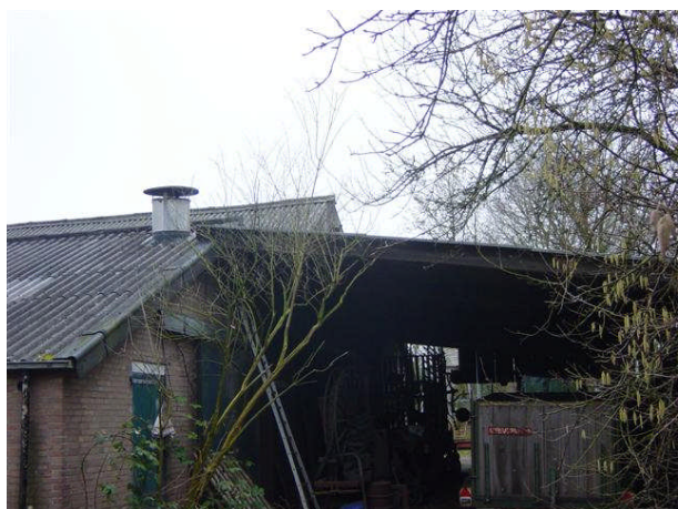
Foto 3, de open loods achter de veestalling 4 en de schuren 5 en 6.
