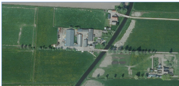
Luchtfoto huidige situatie.
