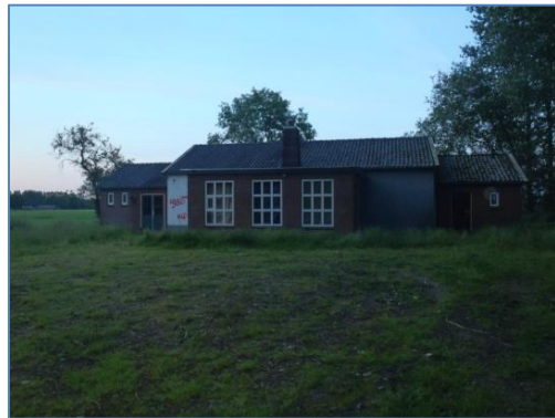
Te slopen gebouw in het zuiden
