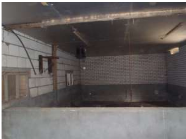
Foto 4: interieur van de varkensstal
