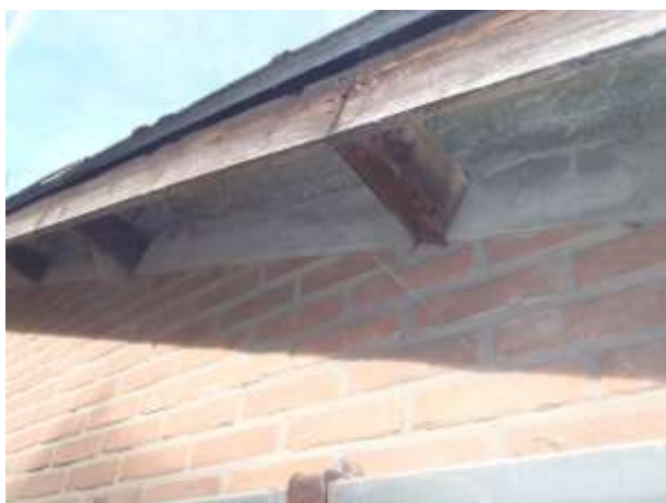
Foto 3: met cement afgedichte kopgevel van de varkensstal
