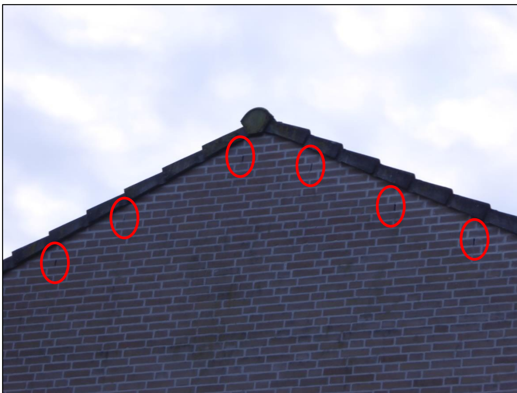
Open stootvoegen in de bebouwing bij deelgebied 2.
