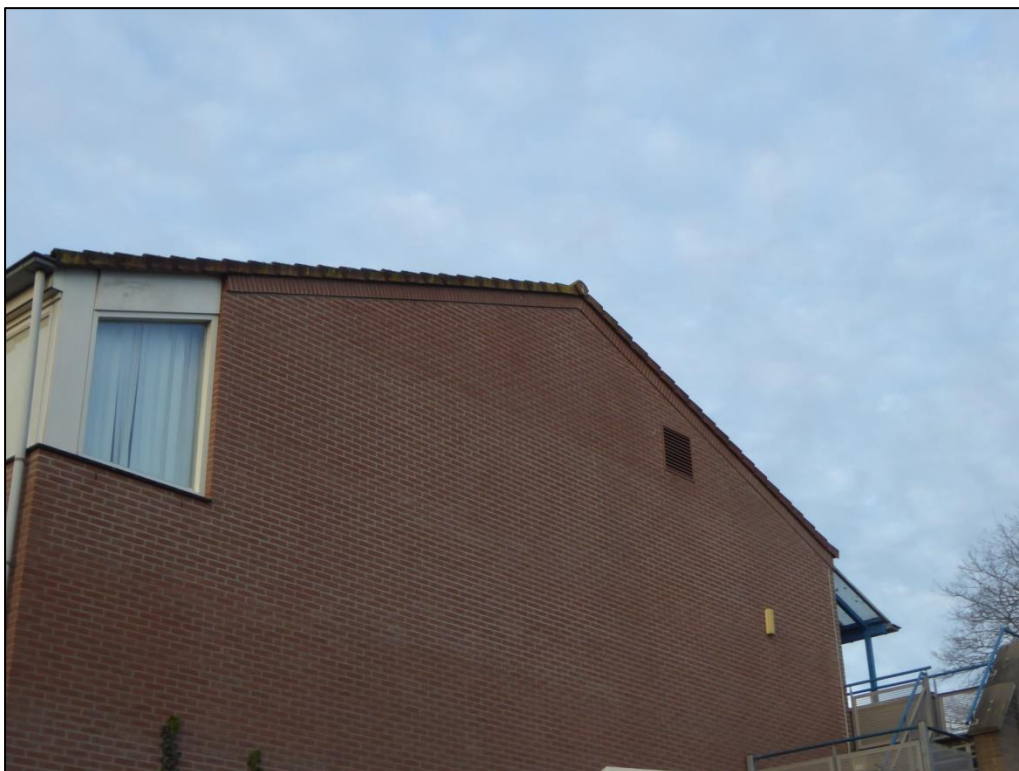
Ruimte onder de nokpan en onder overhangende dakpannen voor de gierzwaluw in deelgebied 2.
