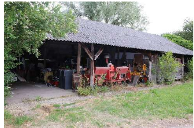
Figuur 4: Opslagplaats machines en gereedschappen
