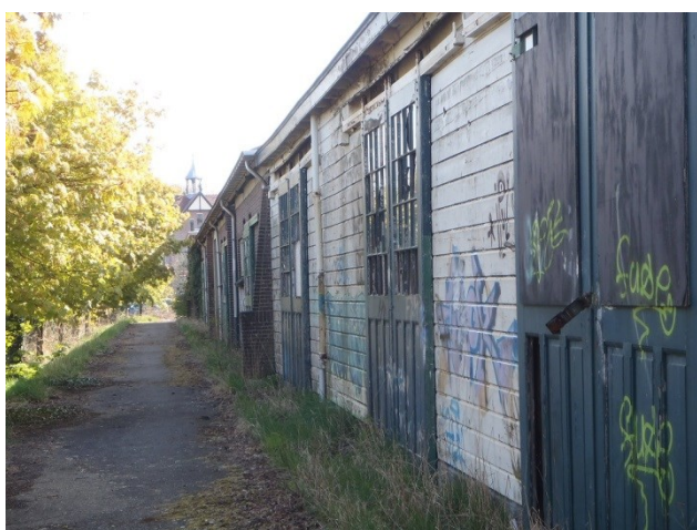
Foto 5: veilinghal 3, de noordzijde langs het spoor met de holle houten wanden.
