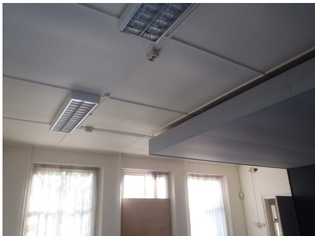
Foto 1: interieur van het kantoor met zachtboard plafond met verlaagd systeemplafond.
