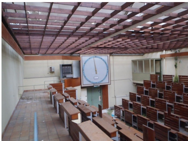
Foto 2: hal met veilingklok boven de planken is een gedeeltelijk beschoten kap aanwezig. Onder de tribunes zijn aan weerszijde kelders gesitueerd.
