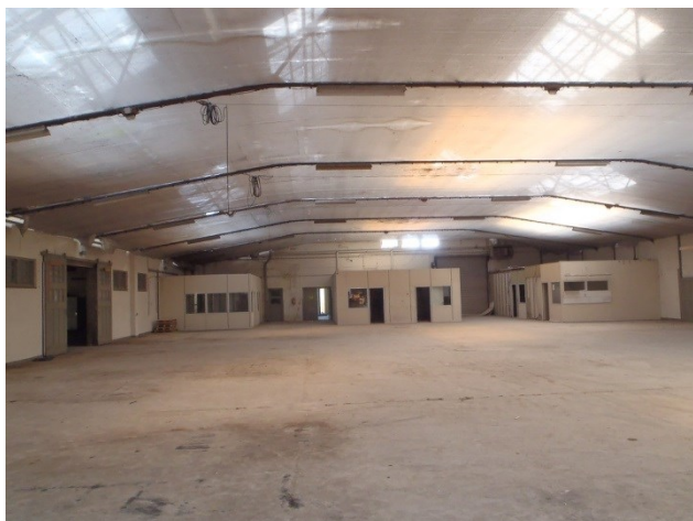
Foto 4: veilinghal 2 met aan de voorzijde enkele kleine kantoorunits.
