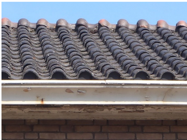
Foto 6: pannendak van het kantoor met goed zichtbaar de vogelschroten die onder de pannen zijn aangebracht.
