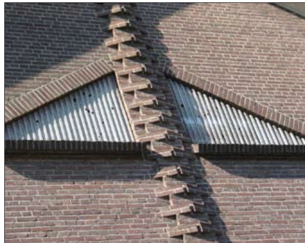
grote loods oostgevel, bouwjaar 1935 raamopening met middenstijl in siermetselwerk
