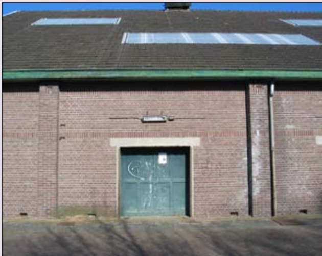
grote loods zuidgevel, bouwjaar 1935 zijmuur met laad- en lospoort aan de Veilingstraat. De bestrating lag vroeger dieper. De poorten waren laadbordessen.
