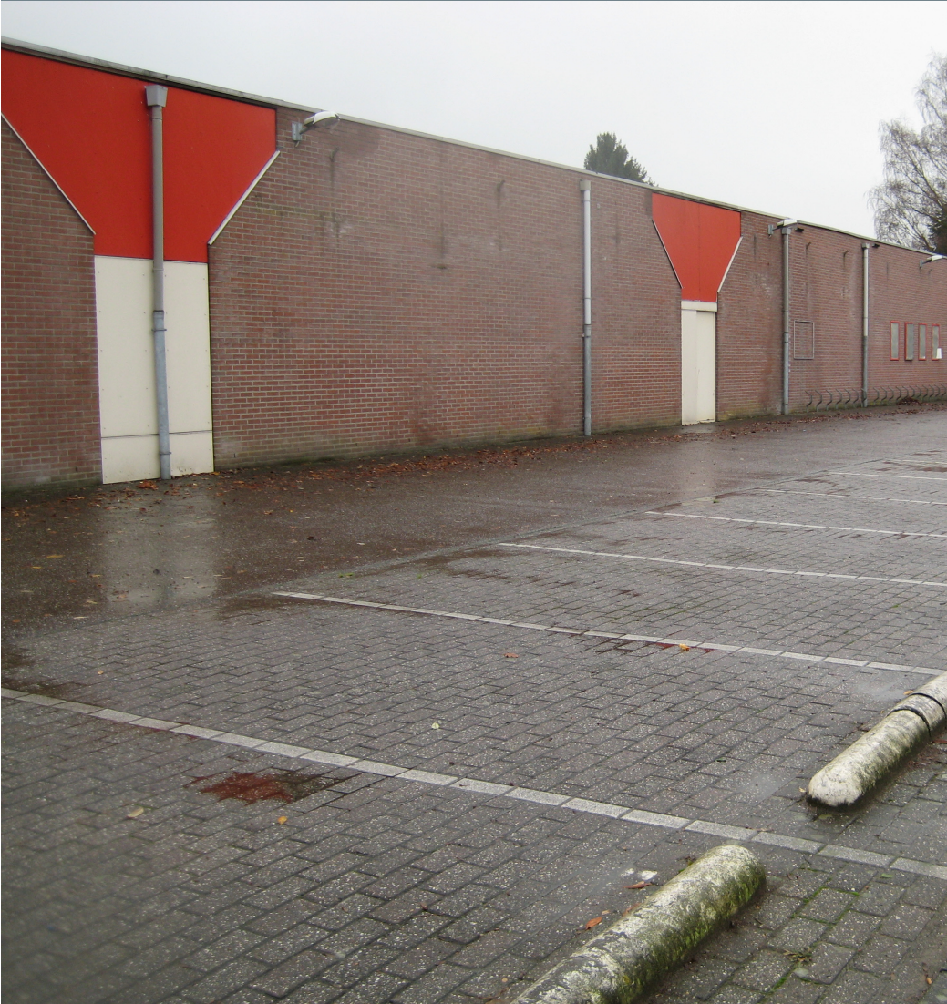
Blinde muur huidige Edah locatie
