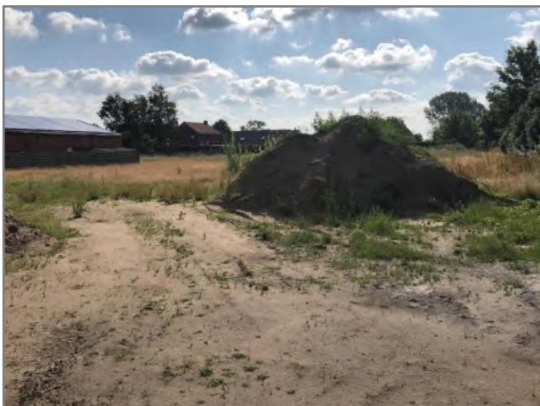
Foto 3: centrale deel perceel 1532
