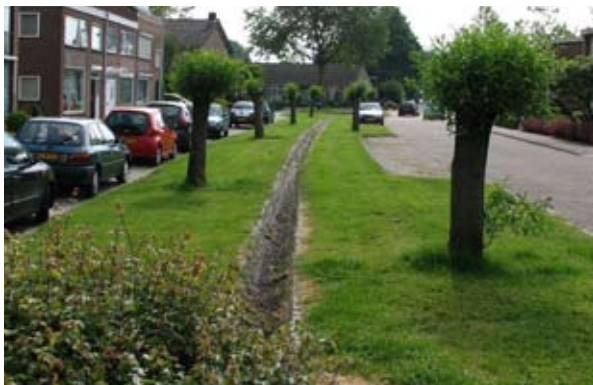
verbeterde waterafvoer in Beek (Wilgenlaan)
