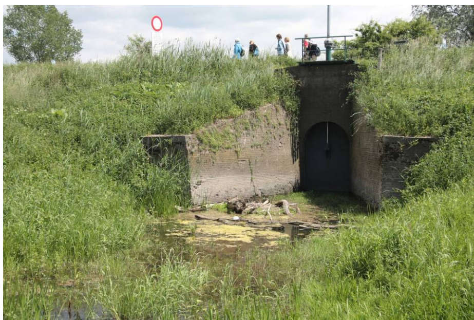
Figuur 2.3 De Waardse Sluis die de watertoevoer naar de Buiten Ooij reguleert, gezien vanaf 't Zeumke. De sluis ligt in de zomerkade.
