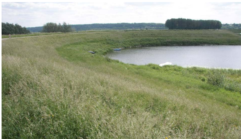
Figuur 2.6 Zicht op de Ooijse Bandijk met het buitendijks gelegen wiel (bijlage 2: thv EN082) waar steenbestorting onder aan de dijkvoet wordt aangebracht.
