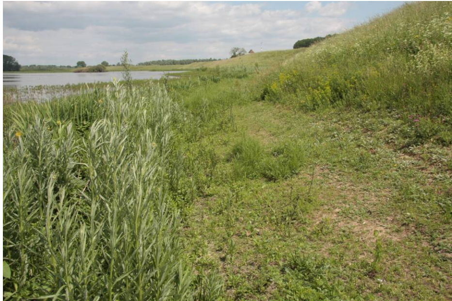
Figuur 3.1 De voet van de winterdijk ter hoogte van de Oude Waal, waar een kleidek zal worden aangebracht. Te zien is hoe in het midden een onderhoudspad is uitgemaaid.
