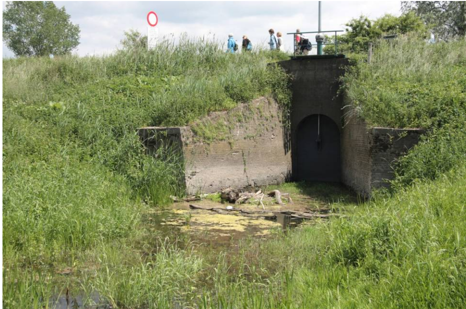
Figuur 2.2 De Waardse Sluis die de watertoevoer naar de Buiten Ooij reguleert, gezien vanaf 't Zeumke. De sluis ligt in de zomerkade.
