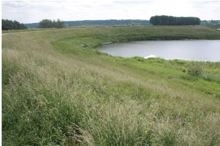
Figuur 2.5 Zicht op de Ooijse Bandijk met het buitendijks gelegen wiel (bijlage 2: thv EN082) waar steenbestorting onder aan de dijkvoet wordt aangebracht.
