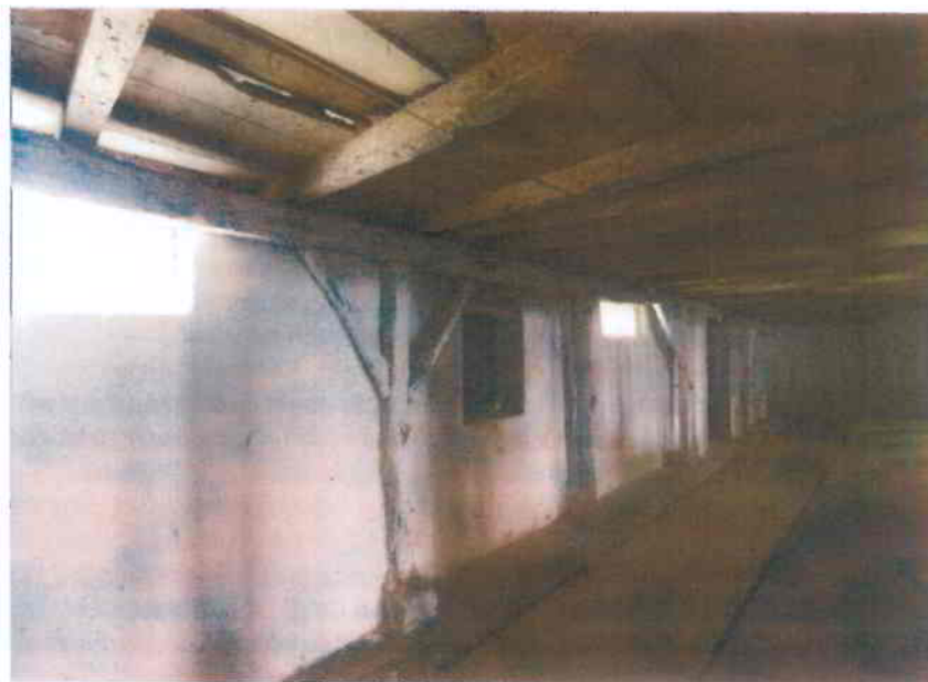
Afbeelding 20 – De witgeschilderde houten vakwerkconstructie, die ooit de rechtergevel van het achterhuis vormde, met daarachter de nieuwere bakstenen muur. De hildes en stalliggers worden gedragen door de houten constructie en de muur, het dak door de muur.
