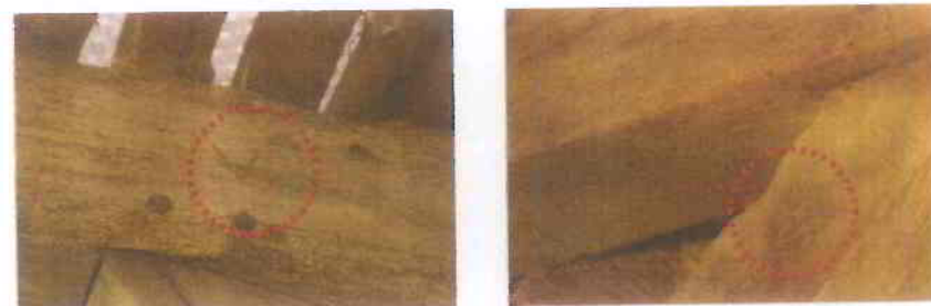
Afbeeldingen 17 en 18 – ankerbalken met het telmerk V en gebintbalkschoor met het telmerk +.
