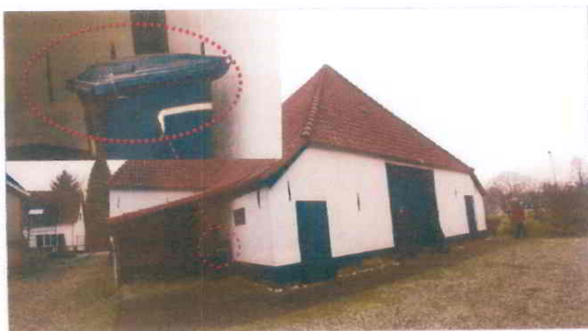
Afbeelding 16 – Achterhuis met aangekapte uitbouw en afdak. De inzet rechtsboven is een vergroting van de rechterzijgevel ter hoogte van de kliko; de muurankers halverwege de muur zijn met rood aangegeven.
