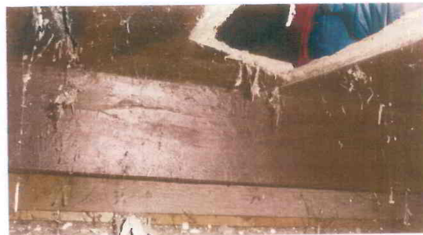
Afbeelding 13 – Een blik op de enkelvoudige balklaag tussen het plafond van de begane grond en de vloer van de zolder van het voorhuis.
