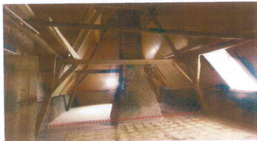
Afbeelding 12 – De kapconstructie in het voorhuis. Ter hoogte van de schouw – daar waar de opkamer begint – is een miniem niveauverschil in de vloer waarneembaar (rode lijn). Links in de foto zijn de vakwerkmuur en de deur naar het bedrijfsgedeelte nog net te zien.
