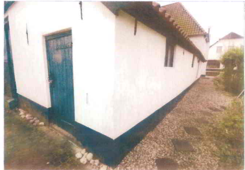
Afbeelding 21 – de linkerkant van het achterhuis vertoont een welving. Deze wordt geïnterpreteerd als de versterking van de voorganger van deze muur, die aan de binnenzijde van deze muur gelopen moet hebben.
