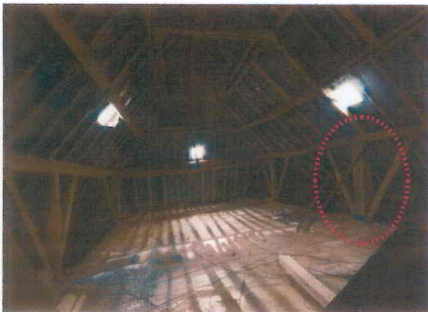
Afbeelding 13 – Een blik op de enkelvoudige balklaag tussen het plafond van de begane grond en de vloer van de zolder van het voorhuis.
