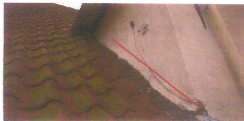
Afbeelding 15 - De achtergevel van het voorhuis, ter hoogte van de aansluiting van deze gevel op het linker dakvlak van het achterhuis. Op de plaats van de rode lijn is een bouwspoor dat een restant van een oude daklijn lijkt te zijn.
