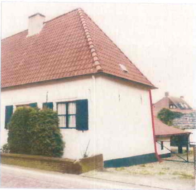
9 Afbeelding 8 – Duidelijk is te zien hoe de zijgevel van het achterhuis voorbij die van het voorhuis steekt (rode ellips).
