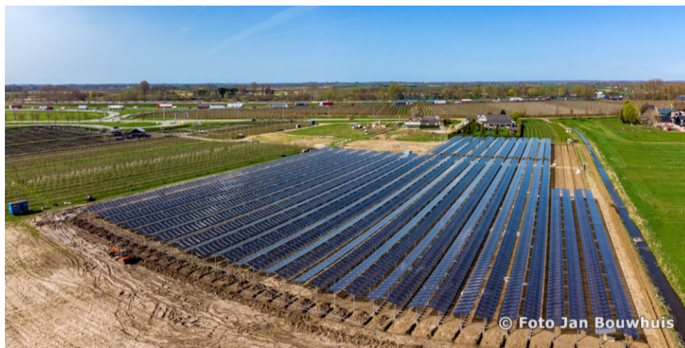
Afbeelding 3.1 Fase 1 in aanbouw (bron: Jan Bouwhuis)
