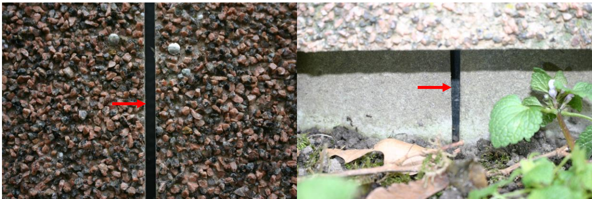
Figuur 4.4.1. De buitengevels van het schoolgebouw zijn met platen bekleed. De ruimte tussen de platen is overal geheel afgedicht (zie rode pijlen). Hierdoor kunnen vleermuizen geen achterliggende ruimtes bereiken.
