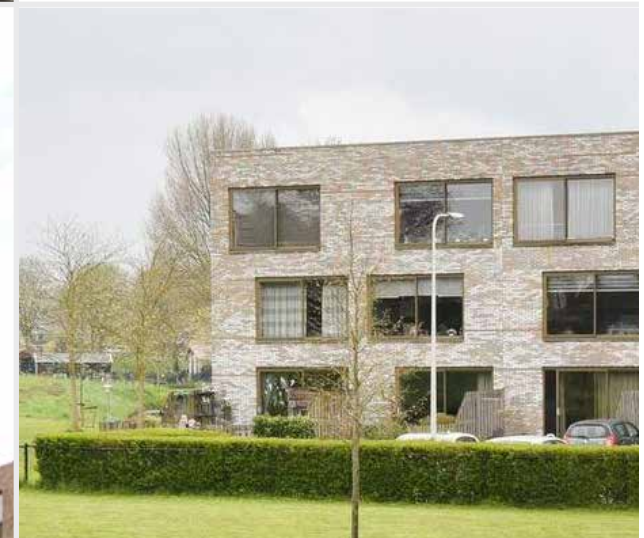
lage borstweringen en grote gevelopeningen © Massa bureau voor Architectuur
