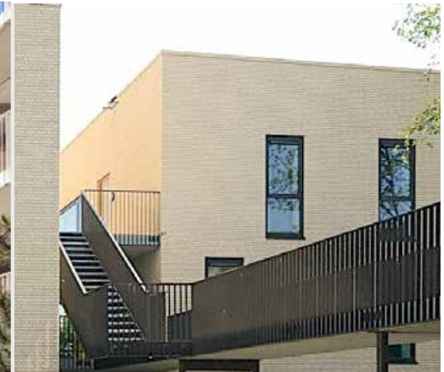
galerijhekken loopbruggen dmv stripstalen voor de balkonplaten langs © Jeanne Dekkers Architecten
