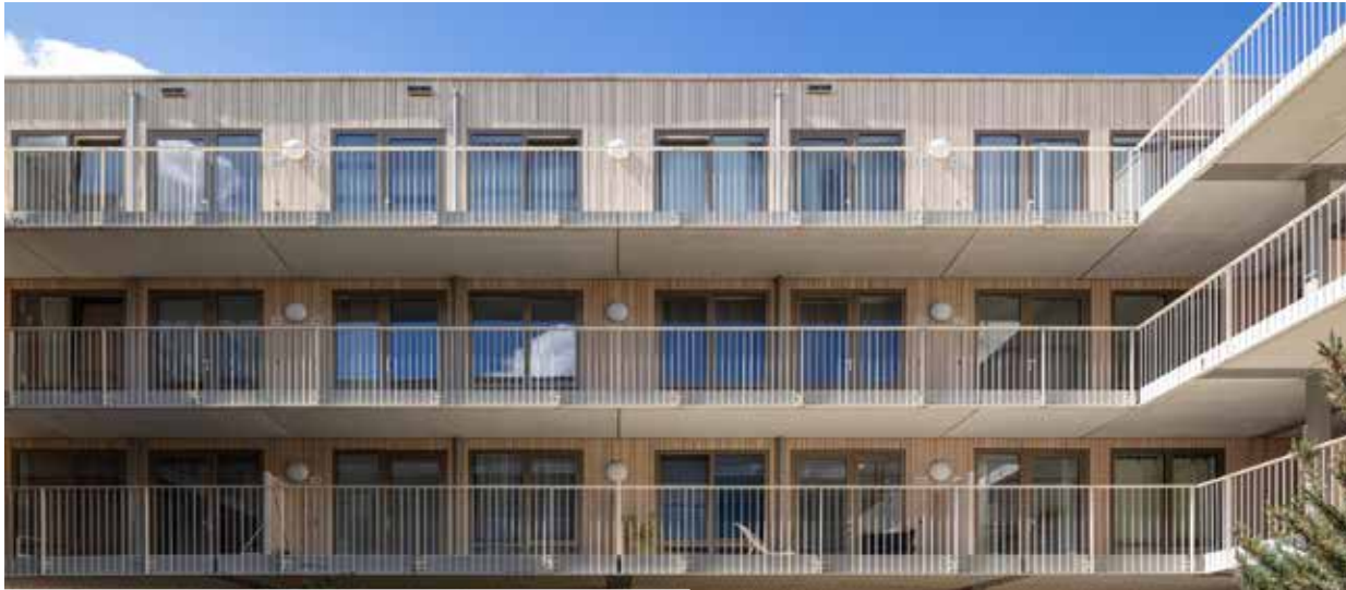
galerij gevel bekleden met verticale latten van hout of houtlook, onzichtbaar bevestigd © Zecc Architecten
