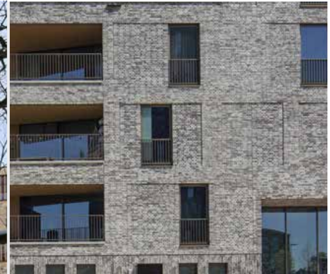
vertikale gevelopeningen en verdiepte vlakken in het metselwerk © Zecc Architecten
