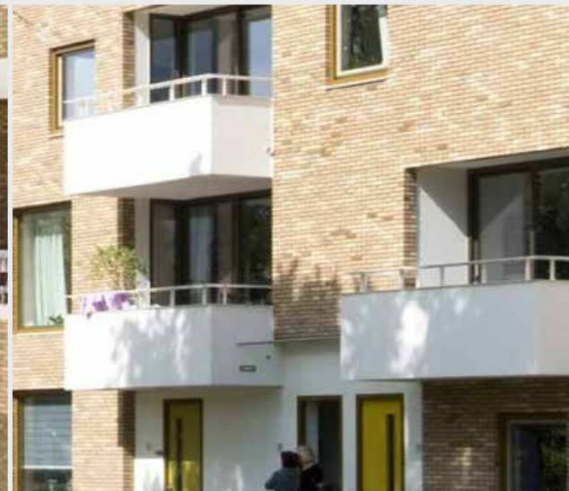
balustrades van de halfverdiepte balkons/loggia's zijn voor maximaal 2/3 dicht.
