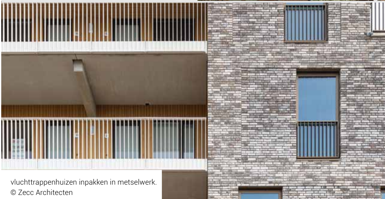
galerij gevel bekleden met verticale latten van hout of houtlook, onzichtbaar bevestigd © Zecc Architecten
