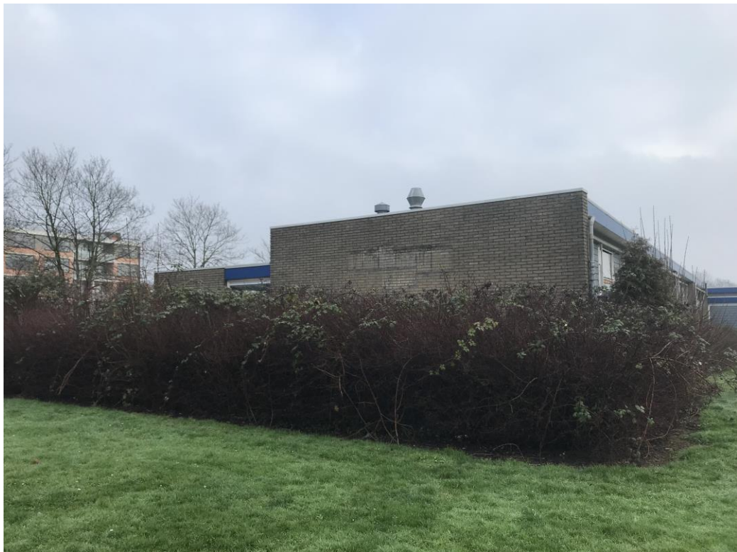
Figuur 7 Braamstruweel waar huismus in is waargenomen aan de westzijde van het schoolgebouw
