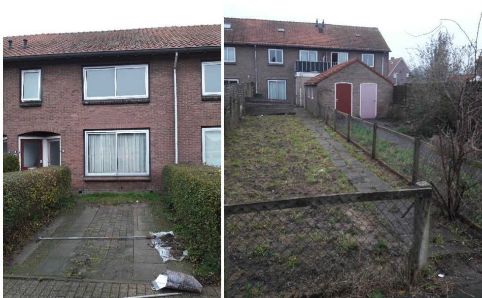
Afb 11. Locatie boring 001, straatzijde.
