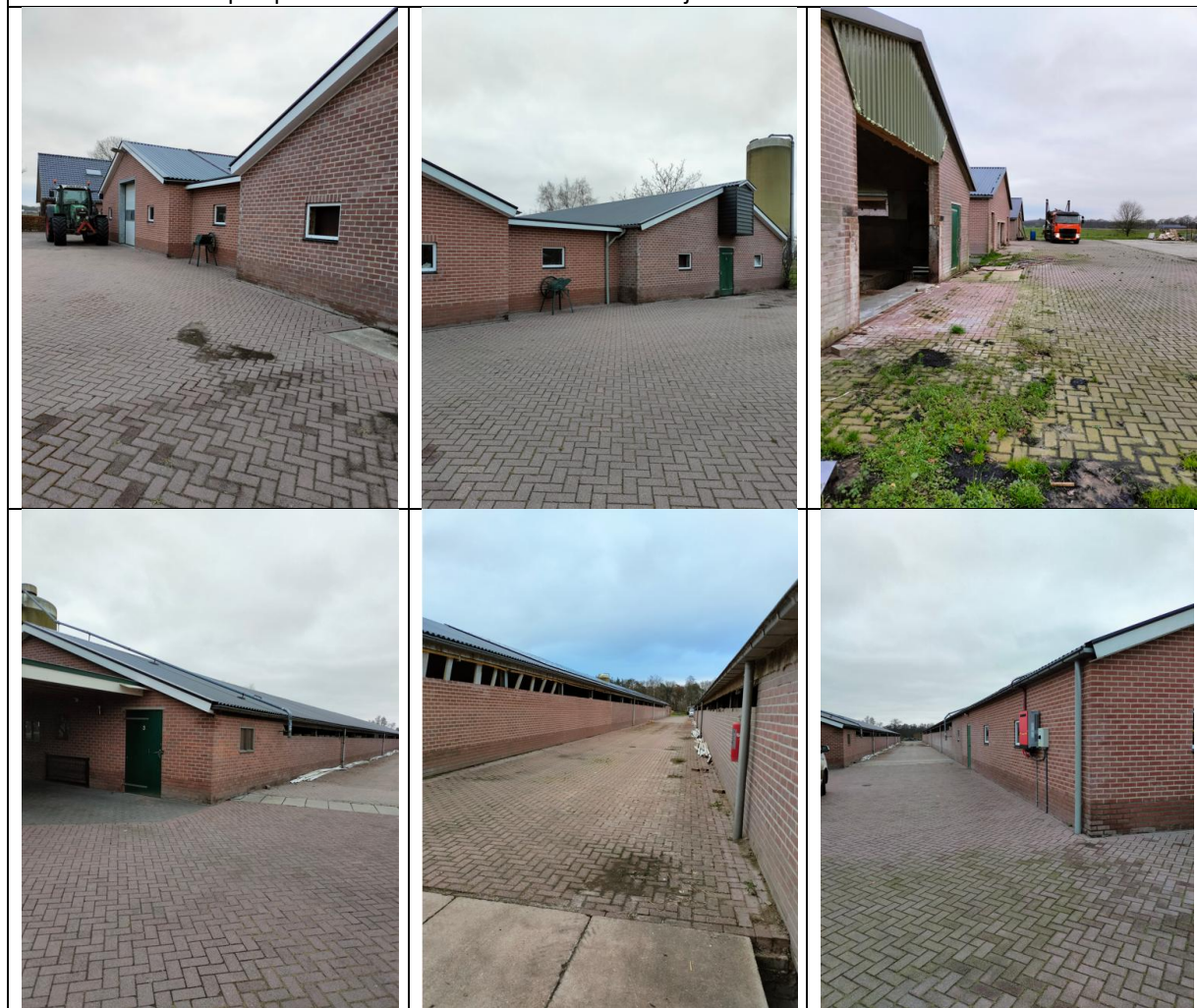
Foto's van de te slopen pluimveestallen vanuit verschillende zijdes
