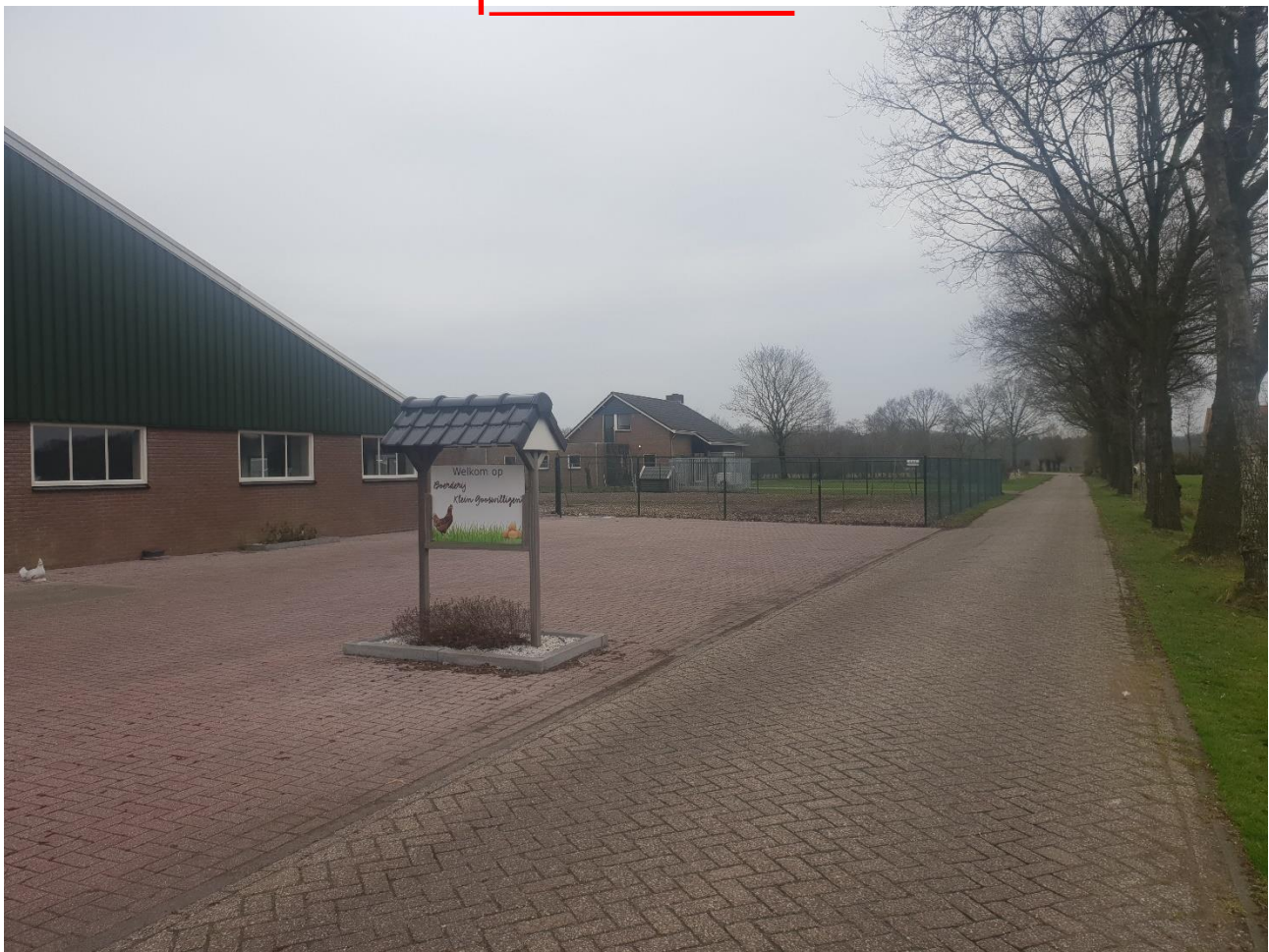
De bedrijfswoning in het besluitgebied met links de pluimveestal van het bedrijf
