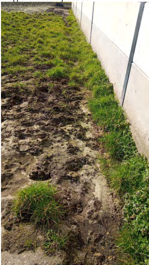
Druppelzone oostelijke schuur
