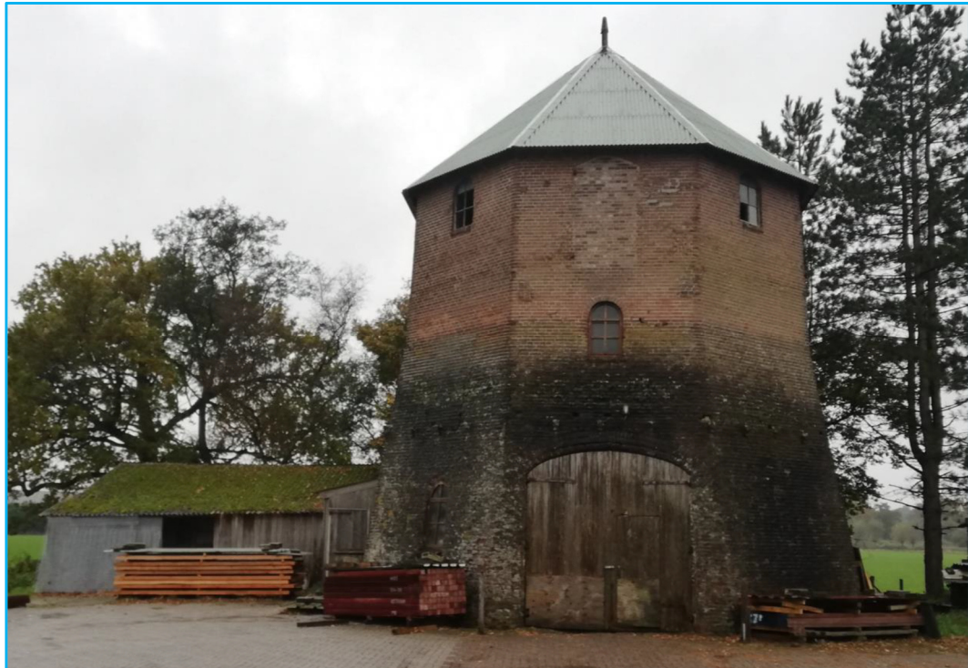
Foto 1: schuur met asbestdakbedekking
