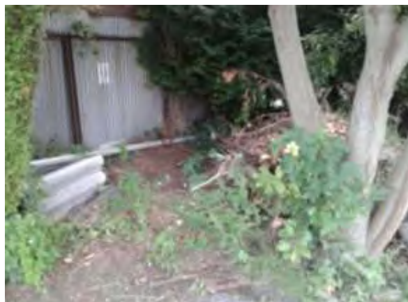
Foto 2: Noordoosthoek met asbestverdacht materiaal
