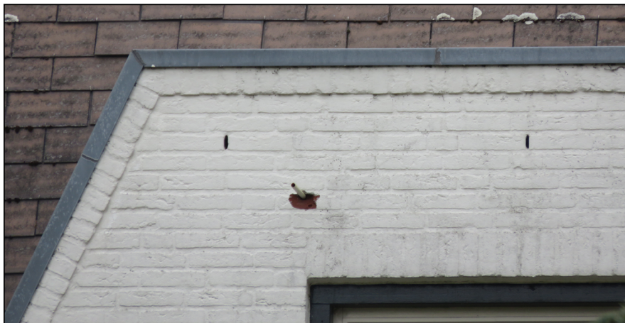
Figuur: het pand ten noorden van het plangebied heeft open stootvoegen op de gevels. Vleermuizen kunnen in de open stootvoegen vliegen en verblijfplaatsen hebben in de spouw.
