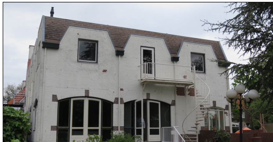
Figuur: de achterzijde van het pand is niet geschikt voor broedvogels, omdat ruimte onder de dakbedekking en openingen in de muur ontbreken.
