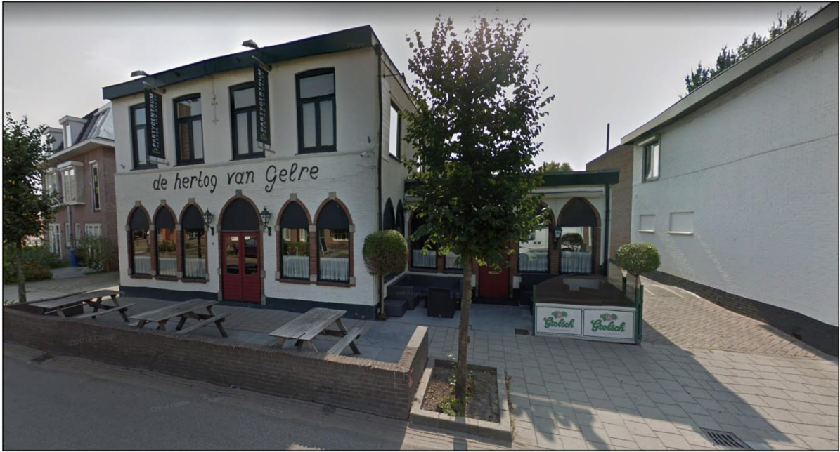
Afbeelding 2.2: Straatbeeld van de huidige bebouwing in het plangebied (Bron: Google Maps)
