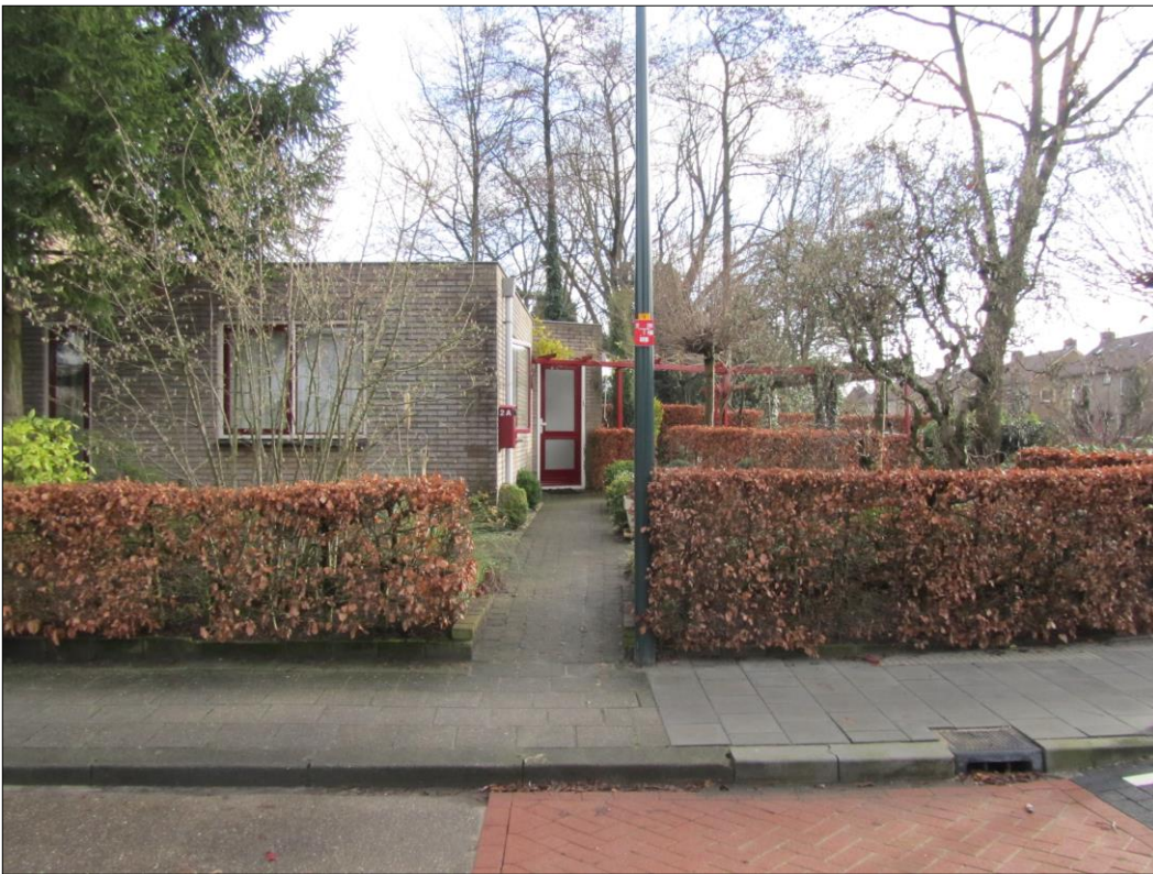
Foto's bestaande situatie
