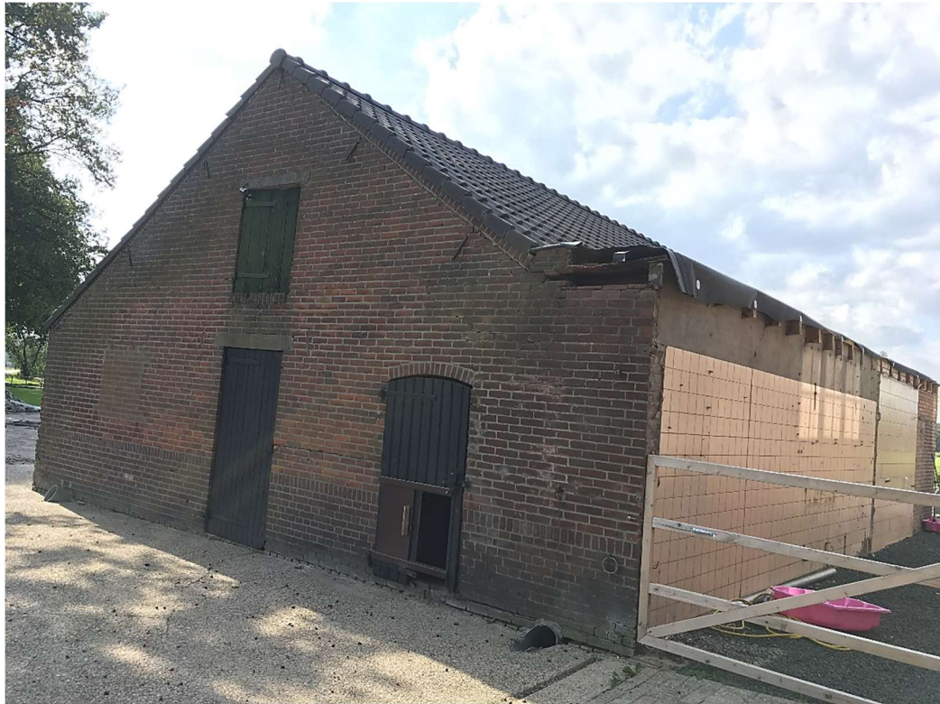
Figuur 3 Rondom de bebouwing is voornamelijk verharding of gazon aanwezig. Het perceel wordt onderhouden met een hoog kwaliteitsbeeld.
