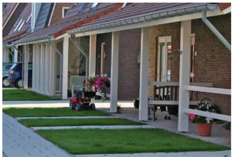
^ Veranda's zijn een mooie verblijfsplek aan de voorzijde en zorgen voor een goede overgang van binnen naar buiten
