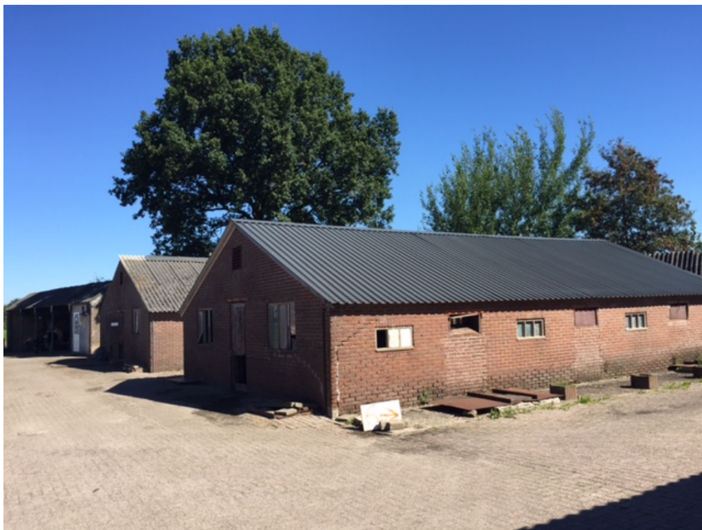
Figuur 3 Alle schuren worden gesloopt ten behoeve van enkele nieuwe woningen. De schuren waren hoofdzakelijk in gebruik t.b.v. vleeskalveren.
