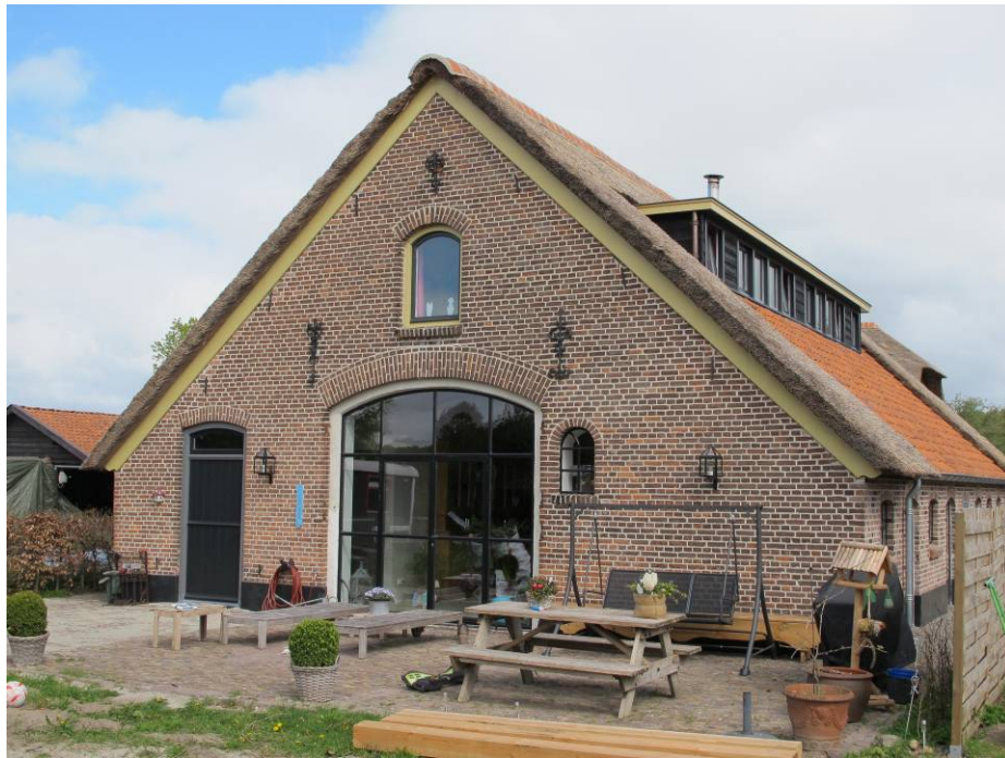
Overzicht van de zuidgevel.
