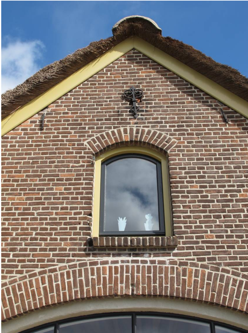
Het bovendee van de zuidegevel. Binnen de oorspronkelijke zolderluikopening werd een nieuw kozijn geplaatst.
