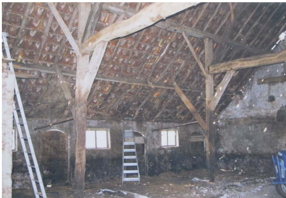
Het interieur van de schuur tijdens de renovatiewerkzaamheden, gezien in noordwestelijke richting. Bron collectie opdrachtgever.
