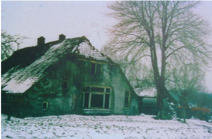
De bouwvallig oude boerderij, gezien vanuit het westen. Rechts van de boerderij zijn de nog aanwezige kastanjeboom en het loodsje uit 1949 zichtbaar. Bron: Collectie opdrachtgever.
