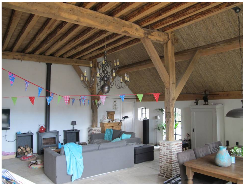
Overzicht van een deel van de gebintconstructie in de aan de zuidzijde gesitueerde woonkamer, gezien in noordoostelijke richting.
