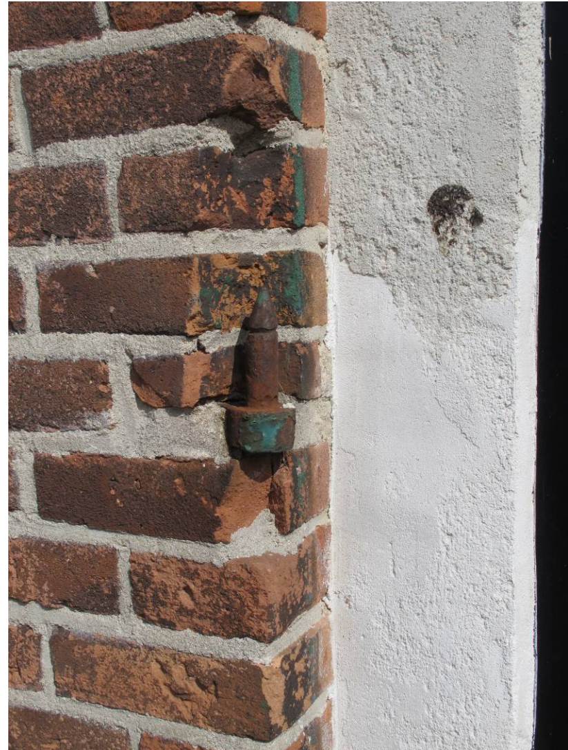
Detail van de nog aanwezige duimen van de oorspronkelijke deeldeuren.
