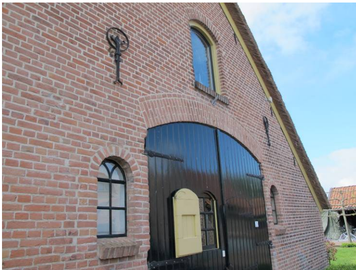
Detail middendeel noordgevel.
