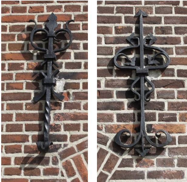
Detail van twee van de opmerkelijk rijk uitgevoerde gevelankers in de zuidgevel.
