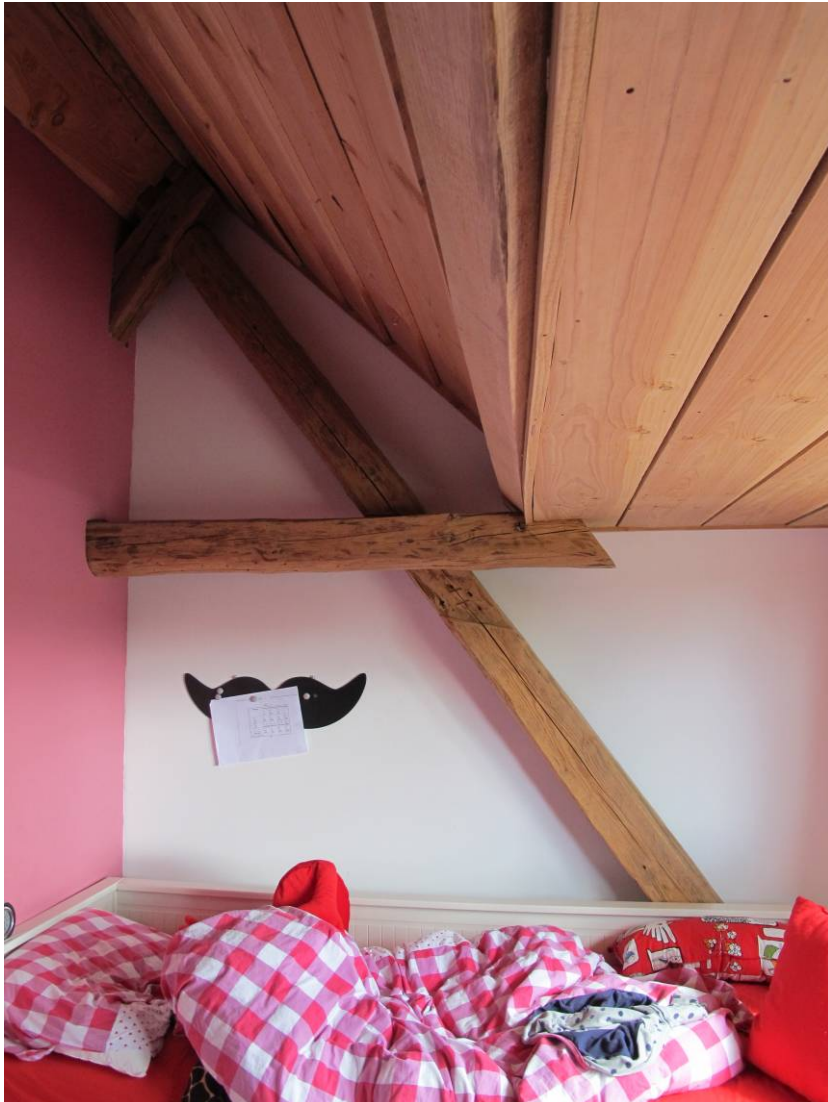
Het in één van de slaapkamers op de verdieping zichtbare deel van een stapels pant.
