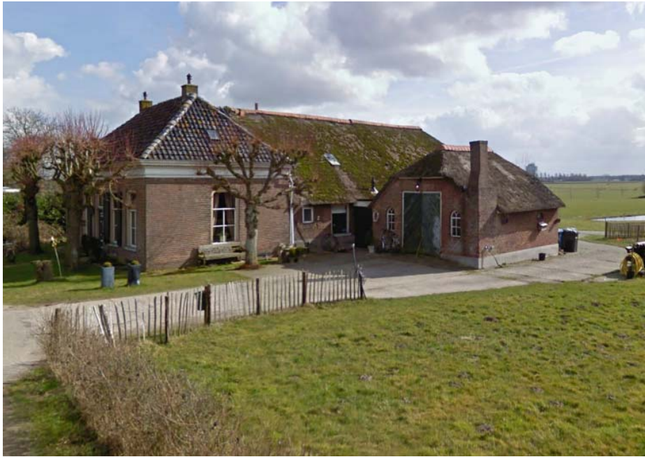
Boerderij met aanbouwde schuur met daarin opgenomen stookplaats in Zwolle. De functie van deze oven is niet bekend. Bron: maps.google.nl
