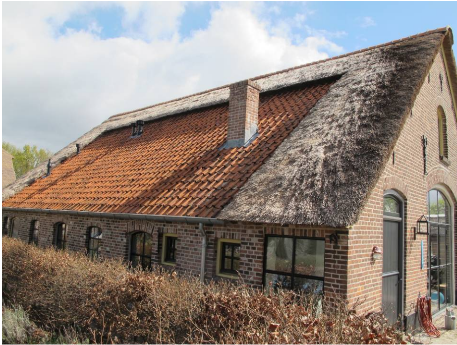
Overzicht van de westgevel en het aansluitende deel van de zuidgevel.
