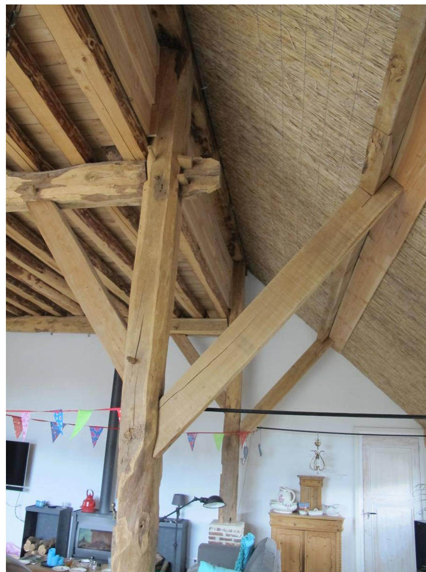
Detail van de constructie in de oostelijke zijbeuk.
