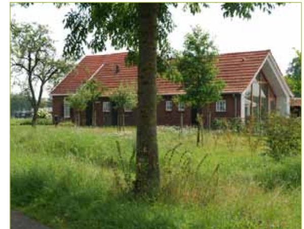
Door de kopse gevel in glas vorm te geven, komt er toch veel licht binnen in de woning.
