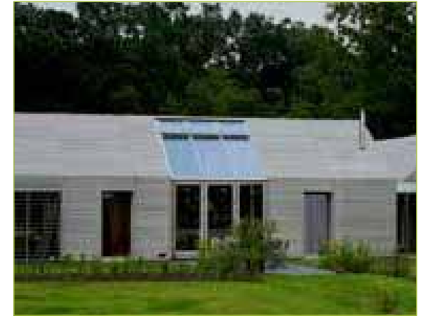
Sobere detaillering en natuurlijk materiaalgebruik passen bij schuurwoningen.
