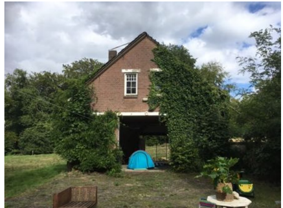
Figuur 4. Westgevel van de schuur.
