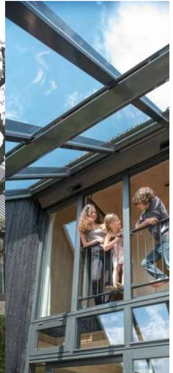
Een uitsparing uit gevel en dak ten behoeve van meer licht/ramen op de verdieping.
