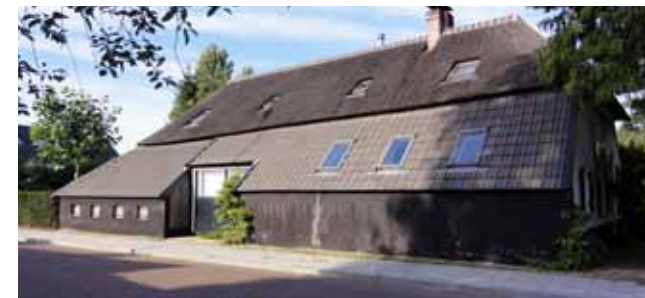
op een deel van de pannen kan riet gelegd worden
