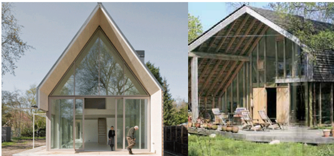
Het dak vouwt zich om het volume.
