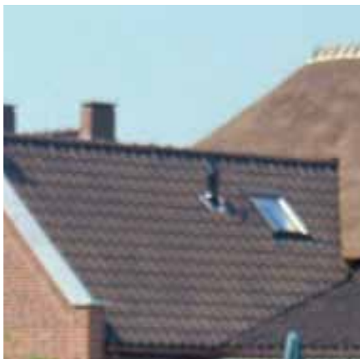
Delen van het dak in riet
