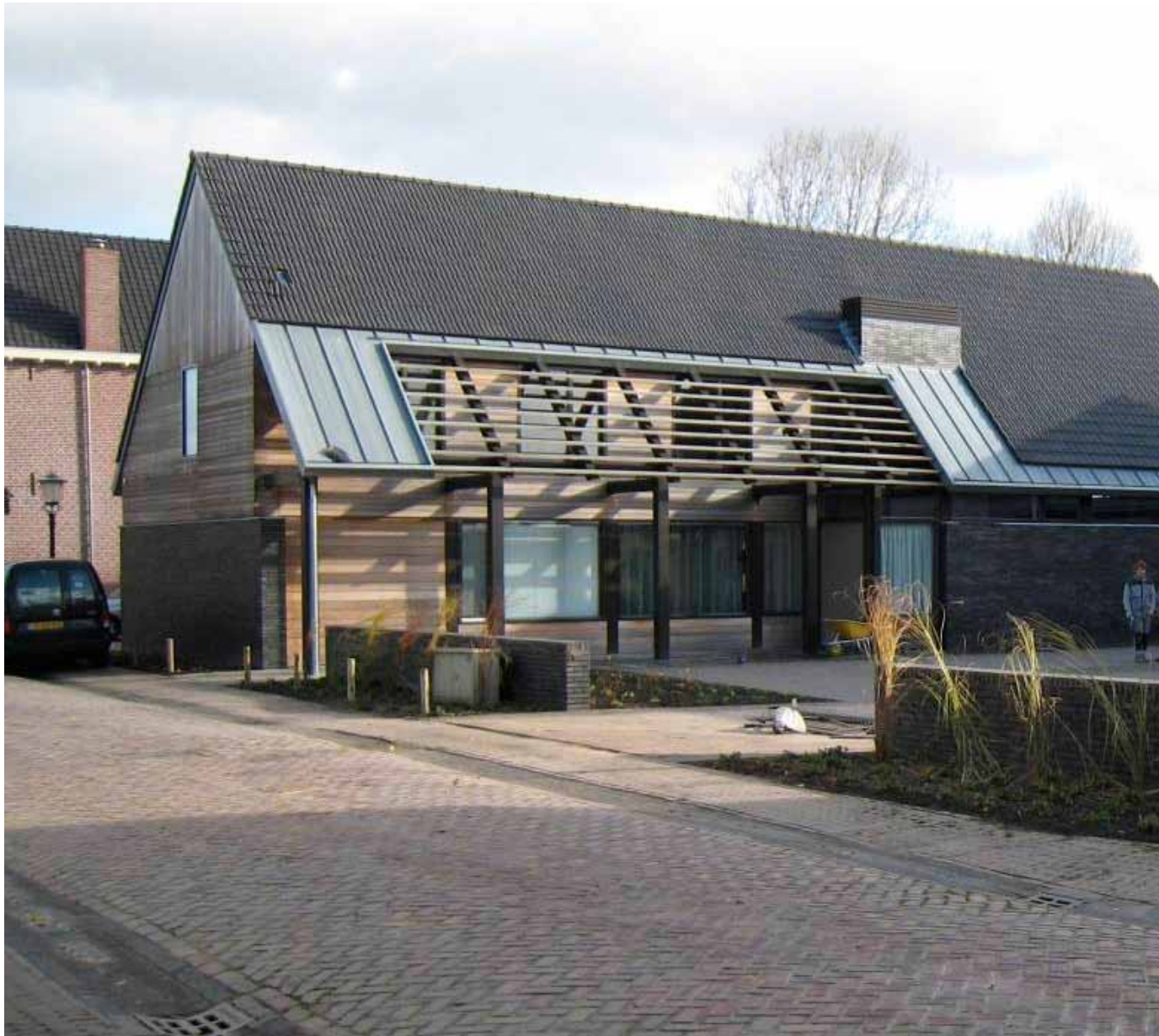
Een hap uit gevel en dak. Dak loopt door als ander materiaal.
