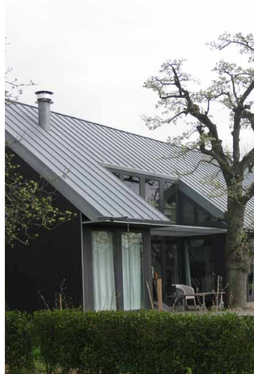
Een uitsparing uit gevel en dak ten behoeve van meer licht/ramen op de verdieping.
