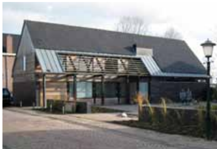
Eén hap uit gevel en dak, dak kan doorlopen als ander materiaal.
