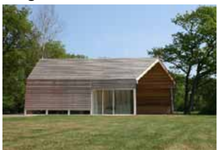
Eén hap uit gevel. Dak kan op een punt hogere goothoogte hebben om genoeg 'vlees' voor de gevel te hebben.
