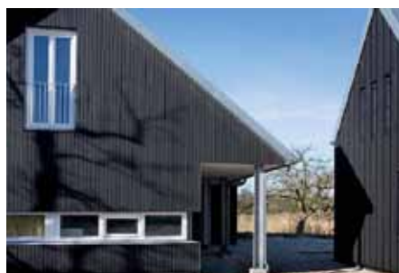
Eén hap onder het dak. De benodigde kolommen dienen in dit geval zichtbaar te zijn als constructieve elementen, minimaal 2 kolommen zijn zichtbaar, als er geen kolommen gebruikt kunnen worden, zie dan 5.: dak als los element.
