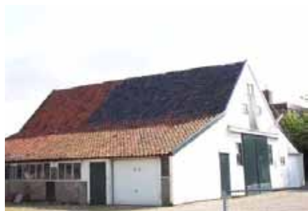
Knik in (een deel van) het dak. De knik is een holle knik.
