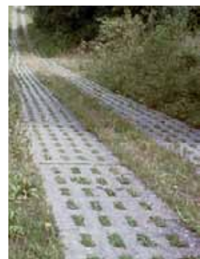
rijspoor van veeplaten
