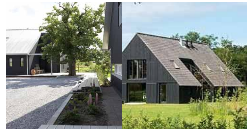
Een hap uit gevel en dak.
