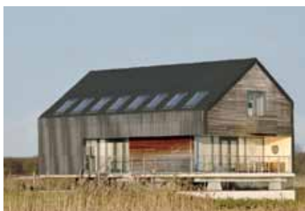
Eén hap uit gevel. Dak kan op een punt hogere goothoogte hebben om genoeg 'vlees' voor de gevel te hebben.
