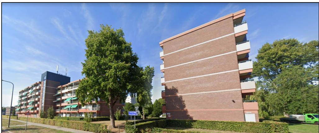
Aanzicht noordzijde van het plangebied, te behouden gebouwen (bron: Google Maps)
