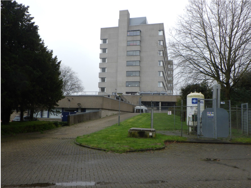
Figuur 9: Zicht op het ziekenhuis vanuit het noorden, kijkend naar het zuiden.
