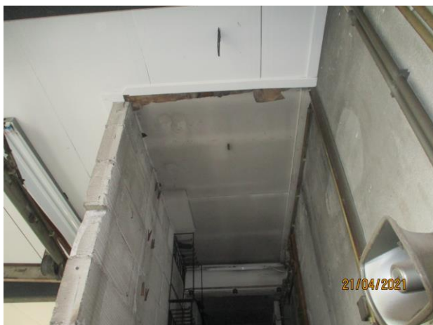
Overzicht plafondbeplating in de open opslagruimte
