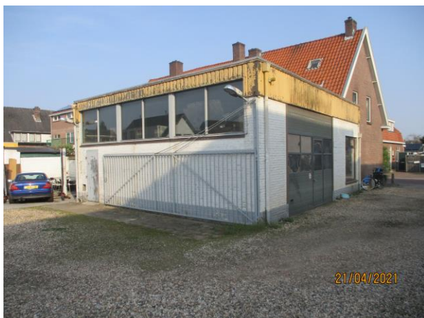
Overzicht gevel met beglazingskit in vaste ramen.
