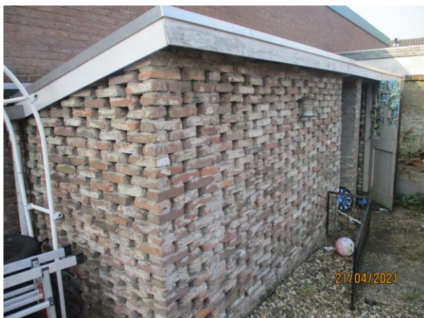
Overzicht tuinschuur met afdichtingskit langs dak
