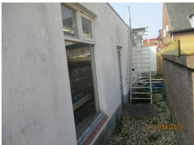
Overzicht zijgevel met beglazingskit vaste ramen
