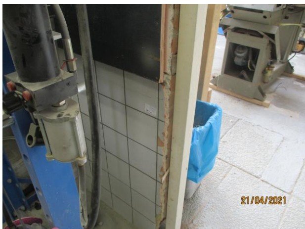
Overzicht wandtegels in werkplaats IJsselstraat 63
