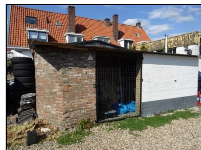
Figuur 8. Te slopen schuurtje en opslag van materialen nabij oostelijke aanbouw.
