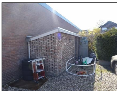
Figuur 7. Te slopen houthok en schuurtje nabij voormalige siertuin.
