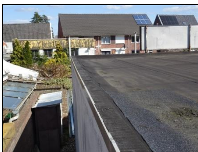
Figuur 6. Zicht vanaf het dak vanaf westelijke aanbouw richting de oostelijke aanbouw.
