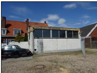
Figuur 3. Oostelijk gelegen aanbouw op de onderzoekslocatie.
