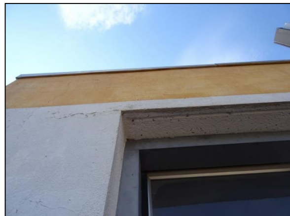
Figuur 11. Gevel zonder invliegmogelijkheden zoals open stootvoegen en strak afgewerkte dakrand bij westelijk gelegen aanbouw.
