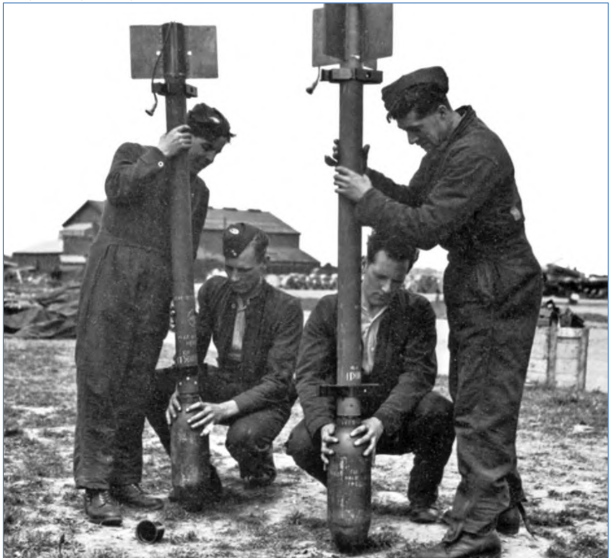
Afbeelding 4: Voorbeeld van 60 lbs raketten, op de foto is te zien hoe het staartstuk wordt geplaatst op de kop (Warhead) van de raket (bron: Wikipedia.com)
