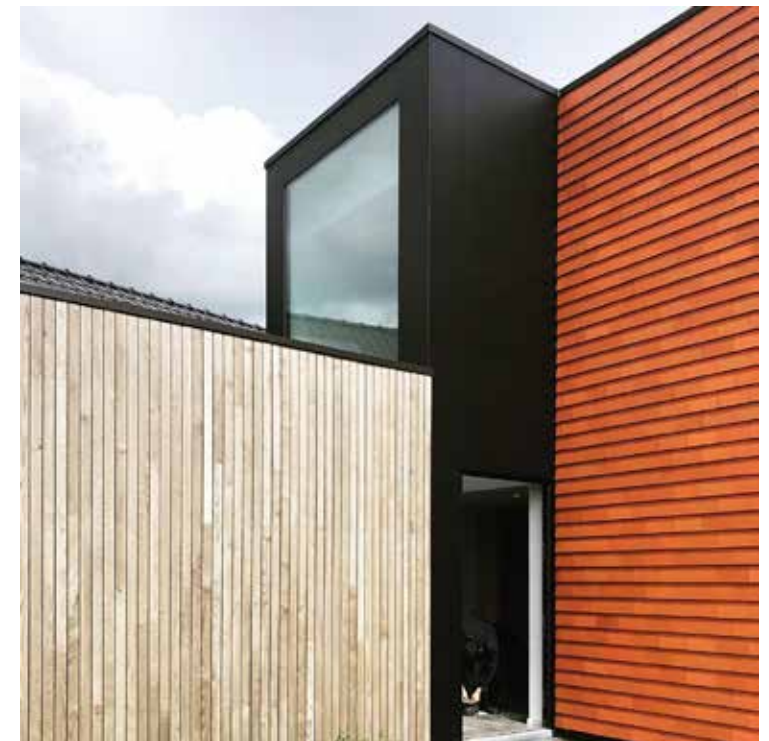
contrast in kleur- en materiaalgebruik, verticaal geled
