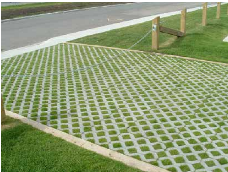
waterdoorlaatbare bestrating op eigen erf, grasbeton
