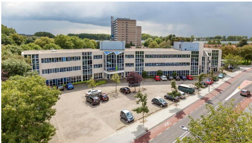
Ligging gebouw aan de Waterstraat 11 te Velp
