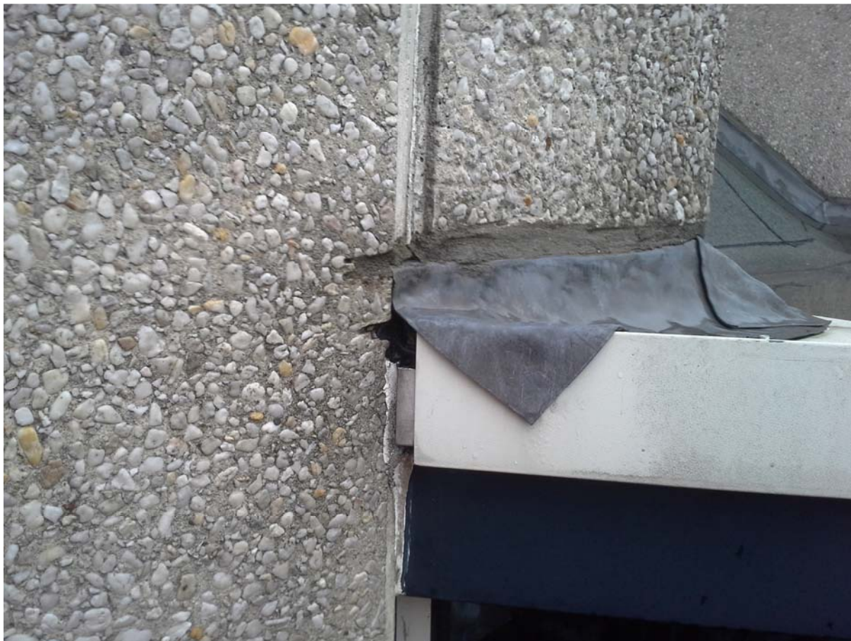
Foto 17: kier uitbouw achterzijde
