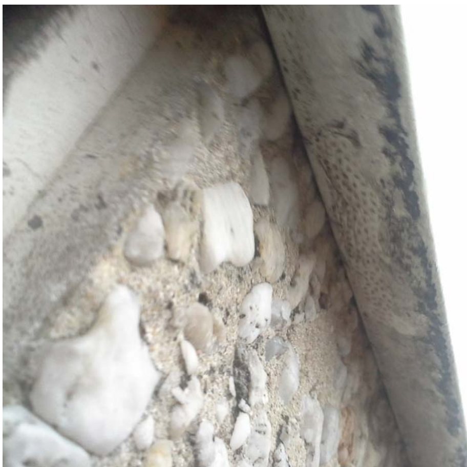
foto 22: aansluiting dakrand gevel
