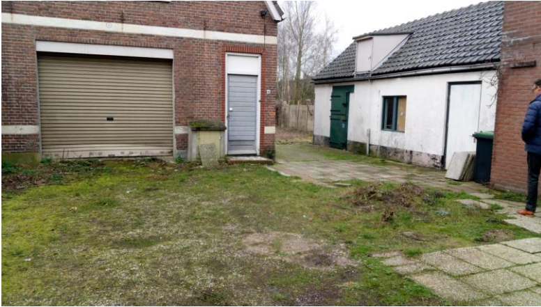
Diverse panden aan de Ijsselstaat 14-16. Onduidelijk wanneer deze gebouwd zijn. Deze zullen gesloopt worden. (Deelgebied B)
