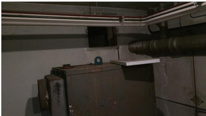
De kruipruimte(n) (zichtbaar vanuit de kelder) onder het kantoorpand Kerkallee 21. Dit pand zal gesloopt worden. (Deelgebied A)
