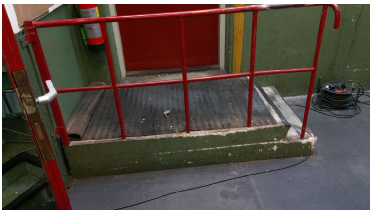
Verschil in vloerniveau tussen kantoor (hoger) en productiehal met sheddaken. Beide panden zullen gesloopt worden. (Deelgebied A)
