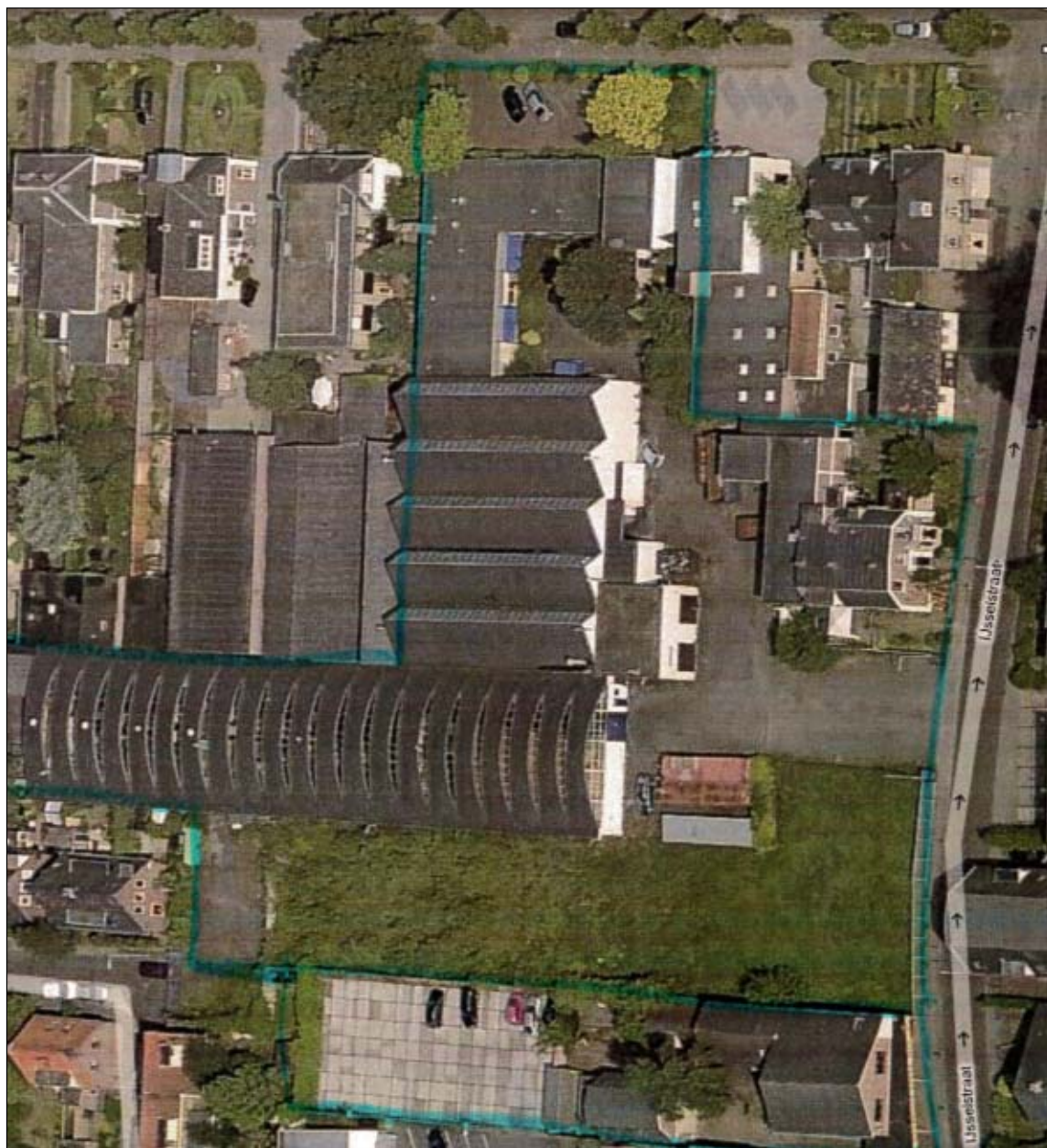
Afbeelding 2: Luchtfoto plangebied huidige situatie (bron: opdrachtgever)
