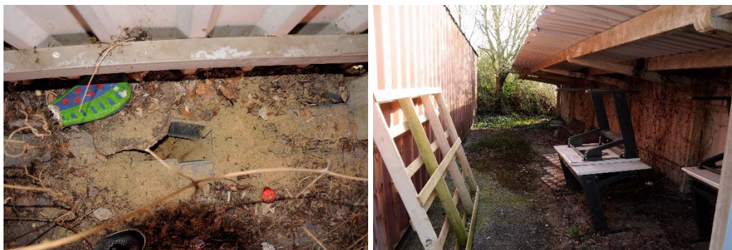
Afbeelding 4. Holte links en locatie rechts. Gelet op de verse grond lijkt de plek bewoond. De bewoner is echter niet vastgesteld.
