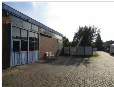
Figuur 4. Zuidzijde bedrijfspand.
