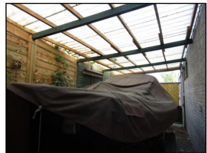
Figuur 5. Houten schuur ten westen van het bedrijfspand.
